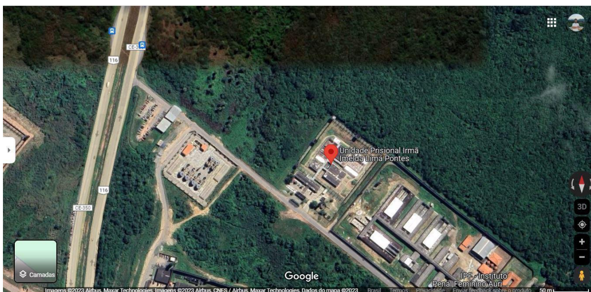
Figura 1 - Imagem Aérea da UP Imelda Lima Pontes
