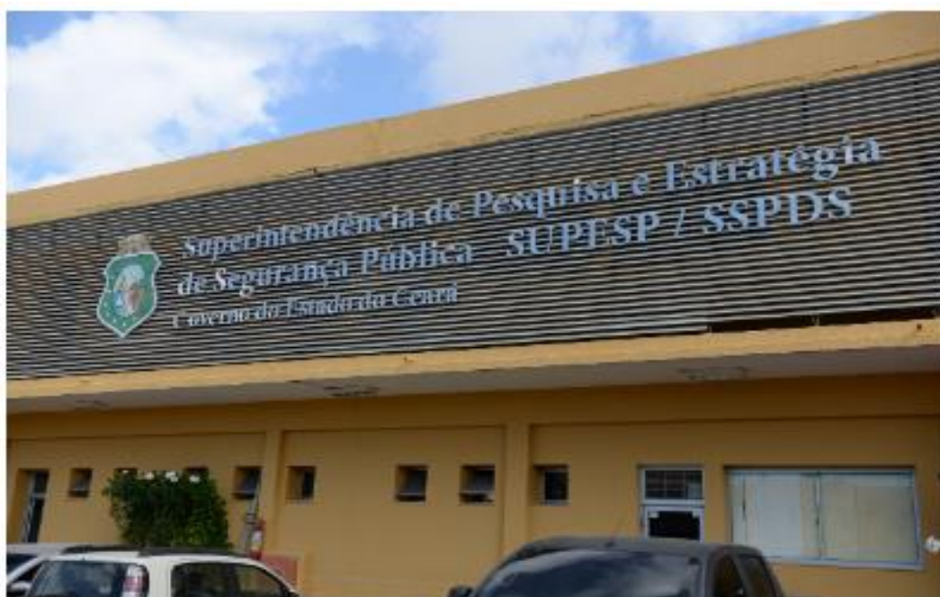
Figura 3: Fachada da Supesp
